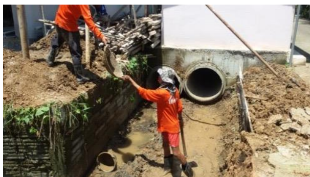
สภาพลำเหมืองเดิมที่ถูกปิดกั้นไม่มีทางไหลของน้ำ และภาพการสร้างท่อระบายน้ำในลำเหมืองเพื่อให้ระบายน้ำได้
